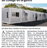
Les deux blocs modulaires sont en cours de finition.
